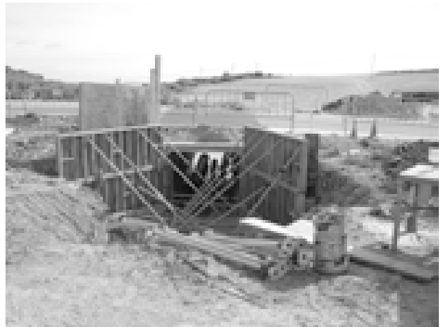
Nueva estructura que encauzará las aguas
